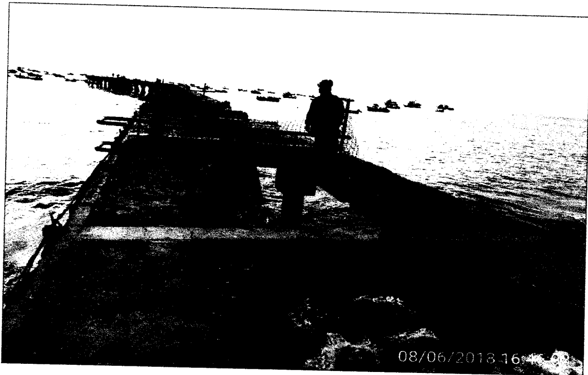
Imagen N°3: A la vista de la imagen se aprecia al trabajador señalizando para impedir el paso al muelle por ser una zona crítica, con sus EPP's completos.
