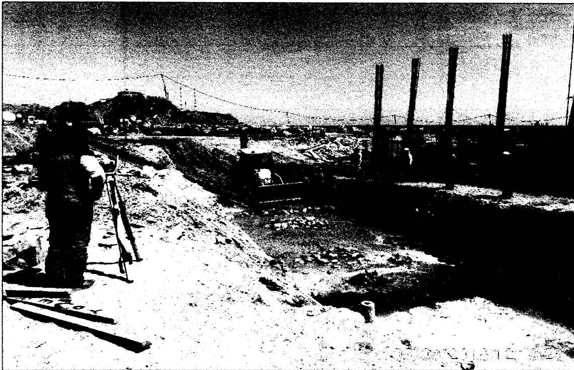
Imagen N°6: A la vista de la imagen se aprecia al Topógrafo realizando trabajos de nivelación topográfica en el área de frío tomando las medidas de seguridad.
