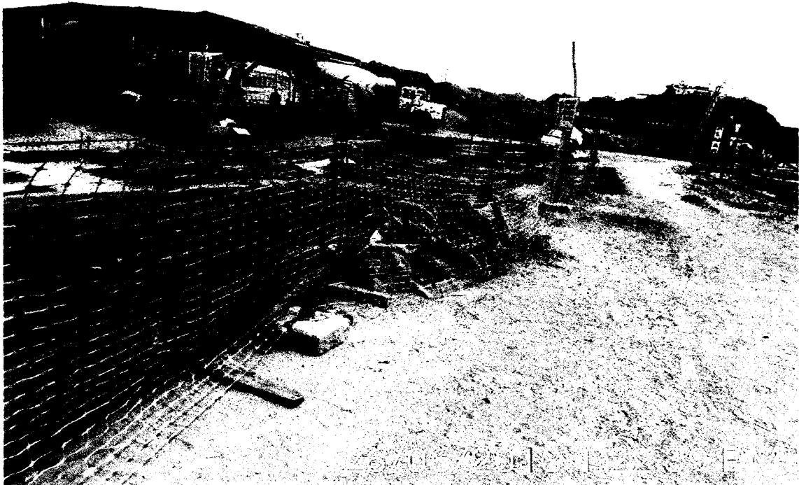
Imagen N°16: A la vista de la imagen se aprecia a los materiales correctamente señalizados, usando las mallas de seguridad.
