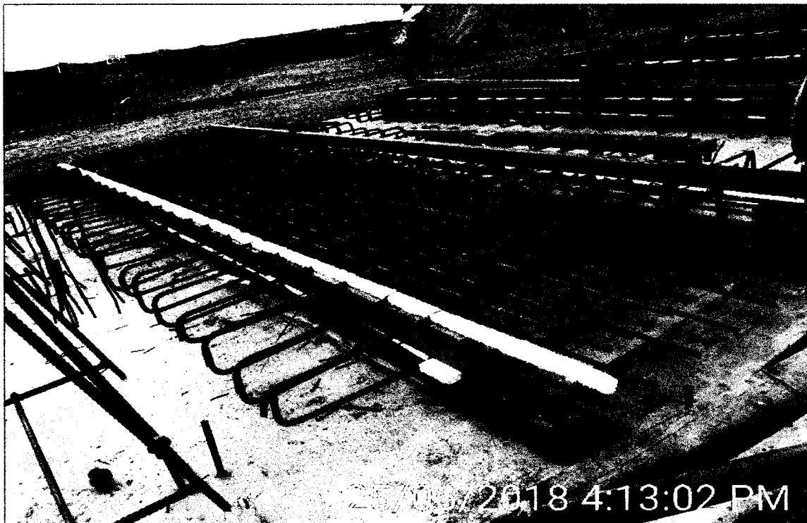
Imagen N°9: A la vista de la imagen se aprecia a los trabajadores que están realizando trabajos de encofrado para el vaciado de las losetas de la plataforma del cabezo del muelle con sus EPP's completos manteniendo el orden y la limpieza.
