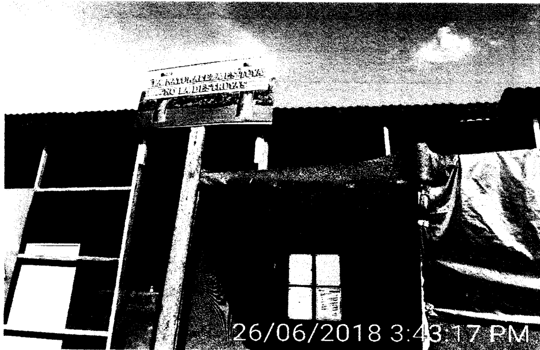
Imagen N° 6: A la vista de la imagen se aprecia el área rotulado con el letrero "La naturaleza es tuya no la destruyas"
